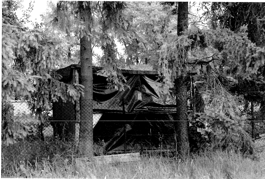
Budynek gospodarczy do rozbiórki.
